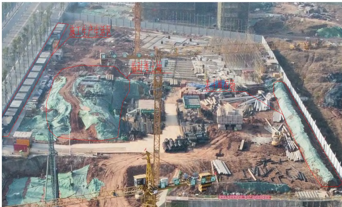
图 1.1-4 临时堆土场情况（施工提供）
