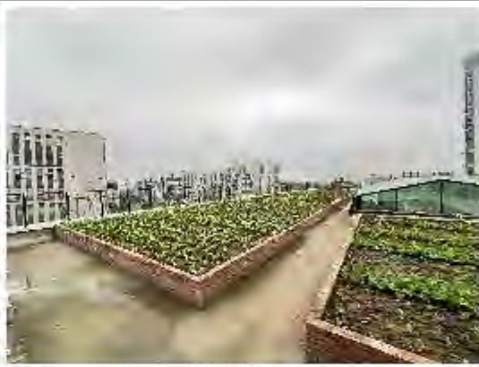
楼顶覆土（2号楼楼顶覆土种植）
