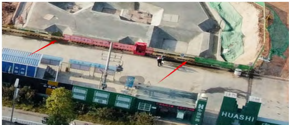
基坑支护结构外边缘布置截水沟
