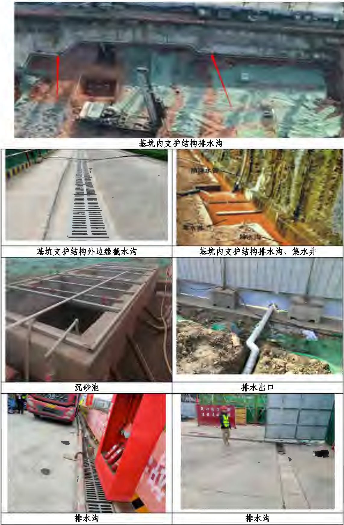
图 1.1-6 施工期间排水
