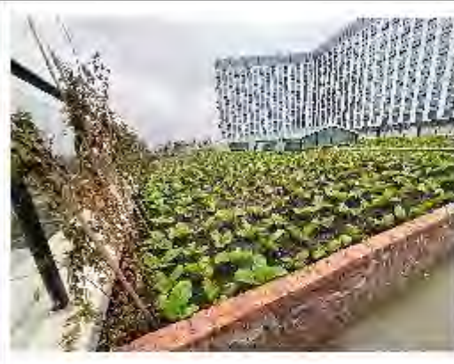
楼顶覆土（2号楼楼顶覆土种植）
