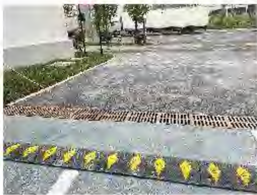
车库出入口截水沟
