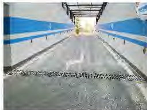
车库出入口截水沟
