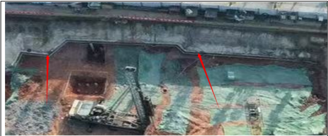
临时遮盖与排水沟 2022 年 9 月
