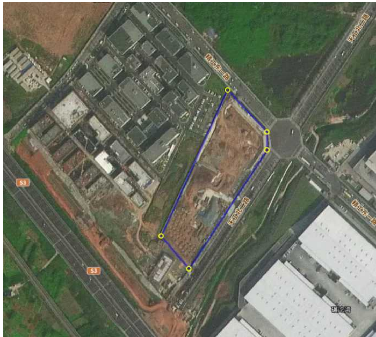
施工期间：2022年10月21日
